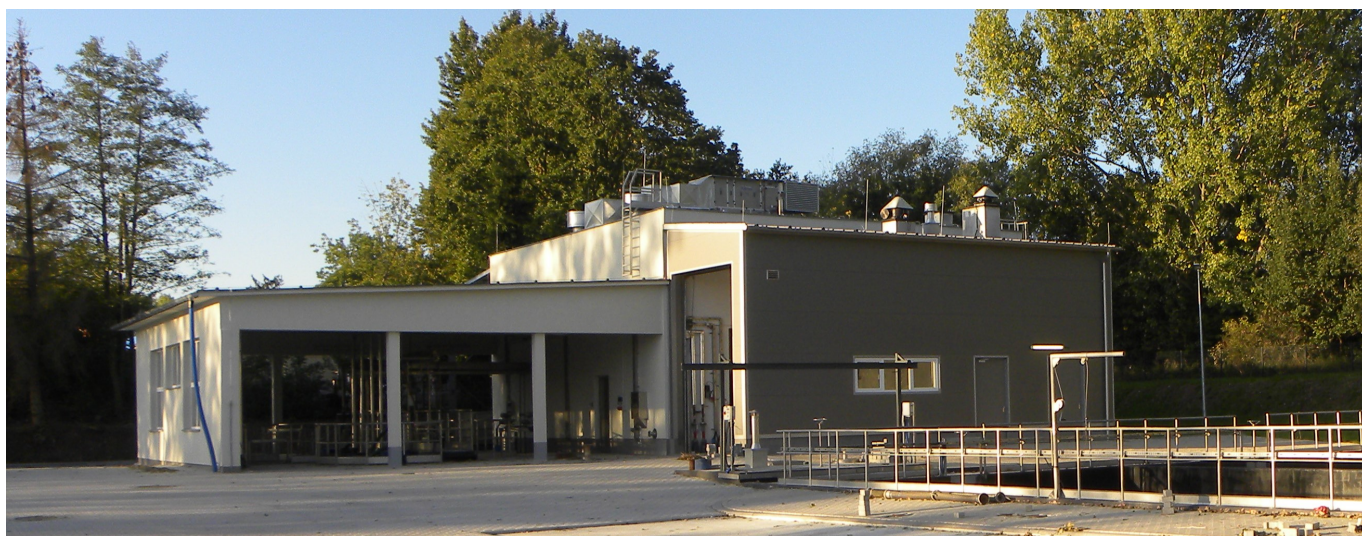
Budynek krat i piaskowników po modernizacji
